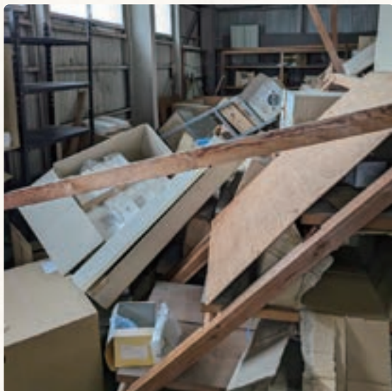
地震直後 棚が多数崩壊しました。
