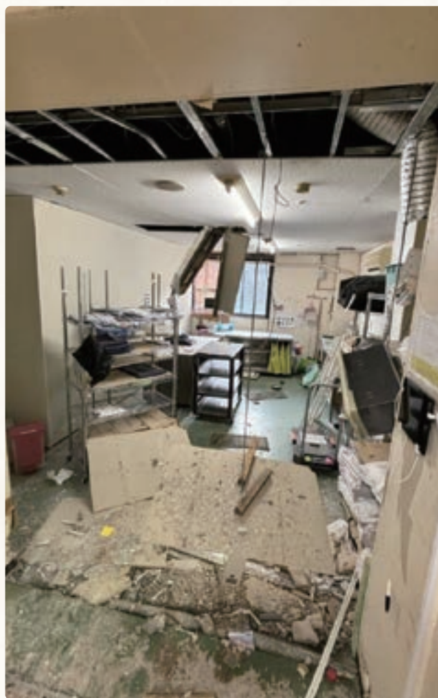
建て増した部分がずれて段差ができた。
