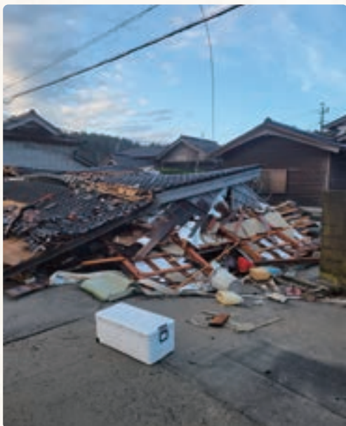
県道を塞いだ近所納屋、住民は車で避難が出来なかった
