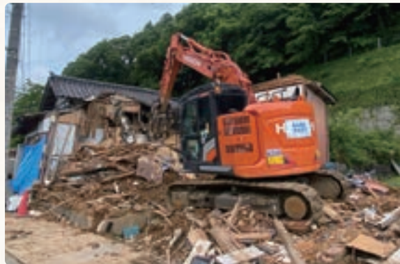
解体現場②
