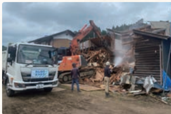
解体現場①
